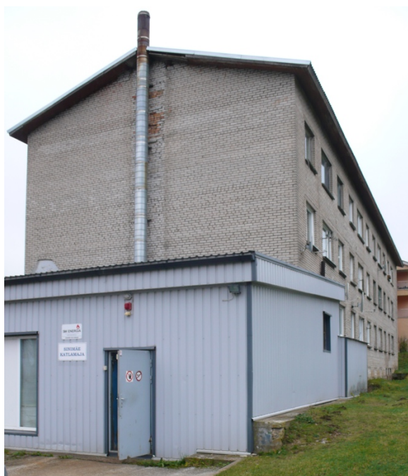
Joonis 5.3 Sinimäe katlamaja paikneb kortermaja otsaseina küljes, mis üldjuhul pole kooskõlas ohutusnõuetega. Foto V. Vares
