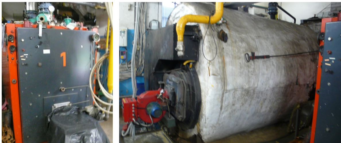
Joonis 5.4 Sinimäe katlamaja katlad, vasakul SM112 ja paremal Kiviõli 80. Foto V. Vares
