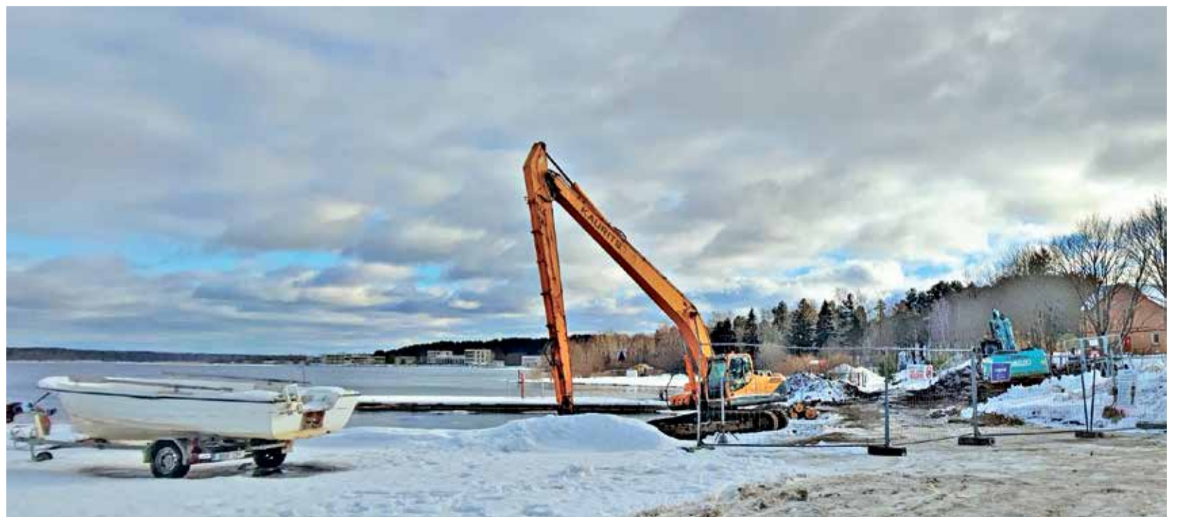
Строительные работы в порту Нарва-Ильяссу. Фото: Кристофер-Мике Таса
