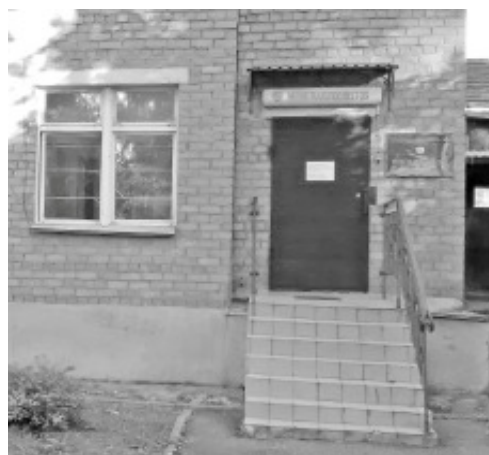
Новый офис Службы Производства. Фото: Марек Ранне
