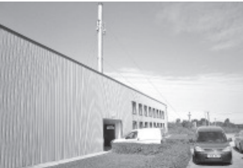
Новая котельная в Ольгина. Фото: SW Energia
